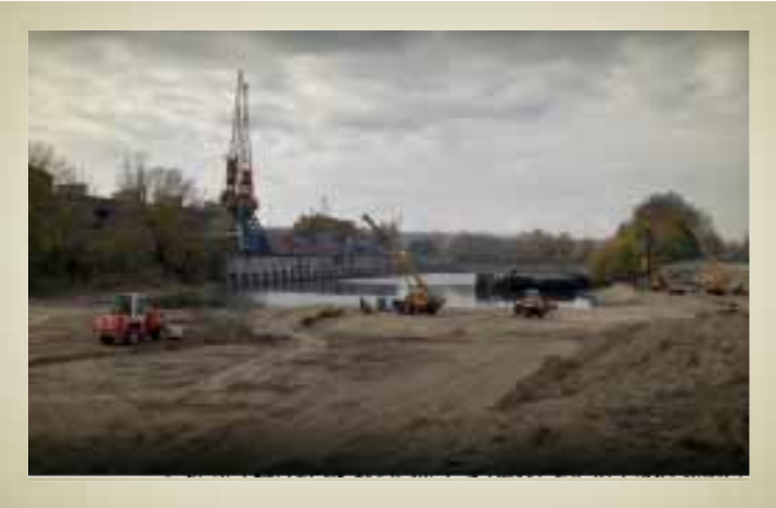
A 2008-ban átadott Ro-Ro kikötőrész építése a csepeli Szabadkikötőben (Budapesti Szabadkikötő Logisztikai Zrt.)
