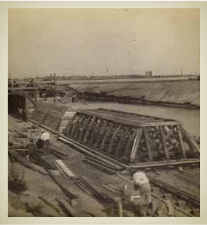
Keszon belső zsaluzása az épülő kikötőben (Duna Múzeum Ltsz.: 24.834.7.)
