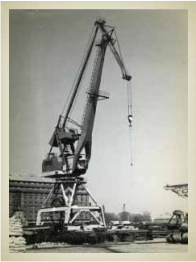
A nyíltrakodón lévő 1979-ben készült 16-27 tonnás billenőgémes portáldaru (Magyar Műszaki és Közlekedési Múzeum TEM.252.5.)
