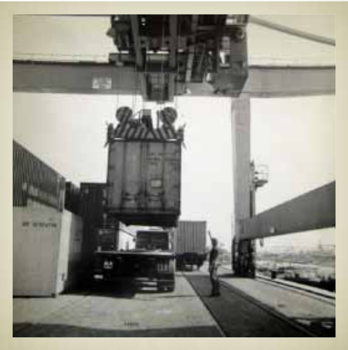
Konténer rakodás egy nyergesvontatóra 1979-ben (MAHART Container Center)
