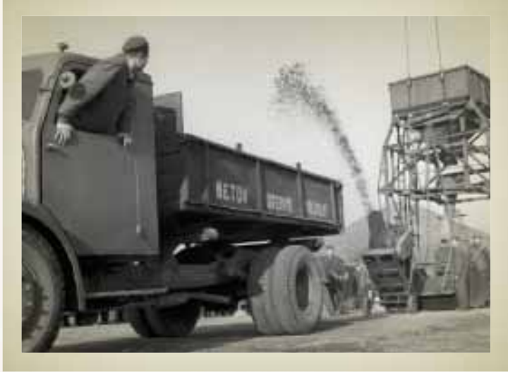
Egy holland gyártmányú rakodógép építőanyagot szór egy teherautó platójára, a berendezés akár 25 méterre is képes volt elszórni az árukat, 1960 (Fotó: Kácsor László, MTI Fotóarchívum)
