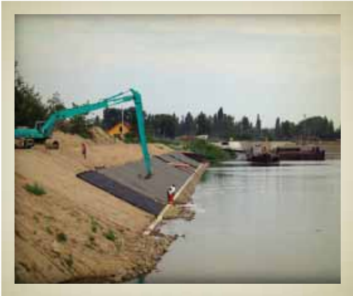
Partfalépítés a csepeli kikötő II. számú medencéjénél (Budapesti Szabadkikötő Logisztikai Zrt.)
