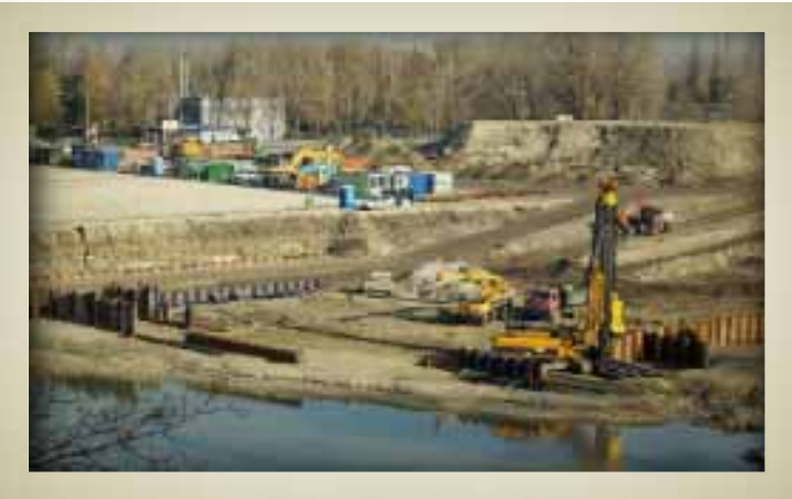
A kikötő új Ro-Ro termináljának az építése (Budapesti Szabadkikötő Logisztikai Zrt.)
