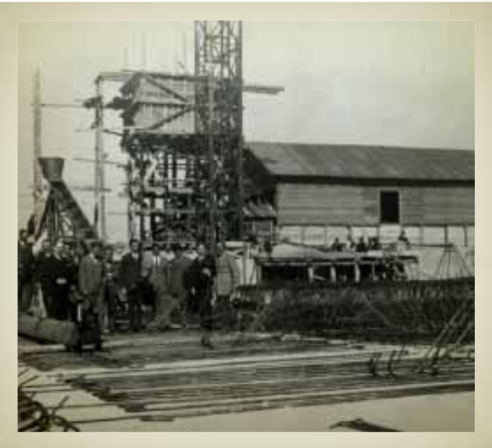
A gabonátárház alapjának és az öntőtornynak a szerelése 1926-ban (BTM Kiscelli Múzeuma Ltsz.: F.74.693.2.)
