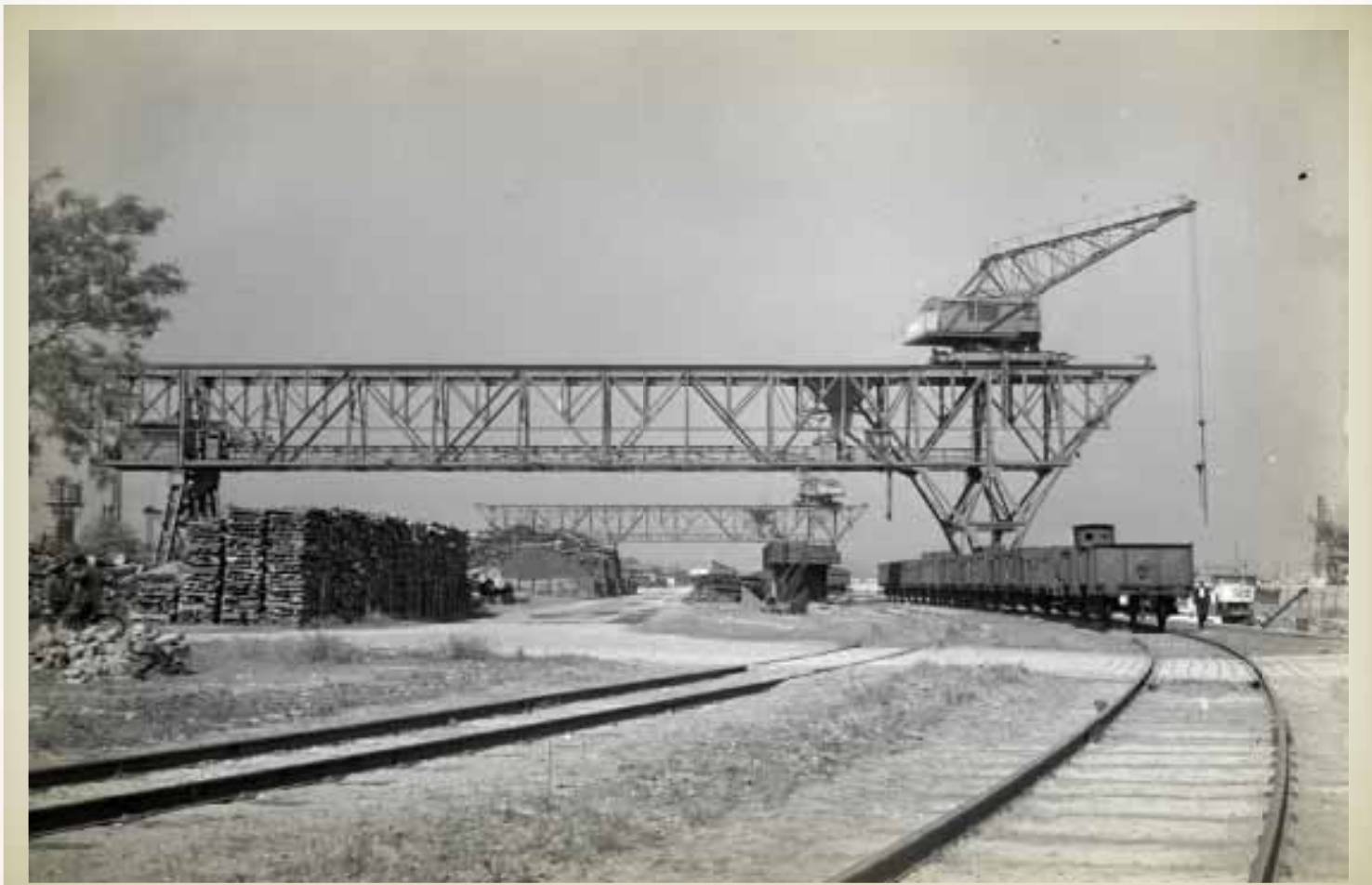
A vasúti nyíltrakodó a csepeli kikötőben (Magyar Műszaki és Közlekedési Múzeum F.40.2010.3.11.)
