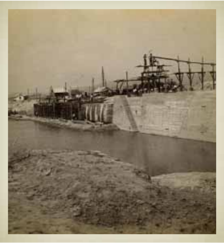
Partfal építése a szárazkotróval, háttérben a vizes kotró (Duna Múzeum Ltsz.: 24.834.8.)
