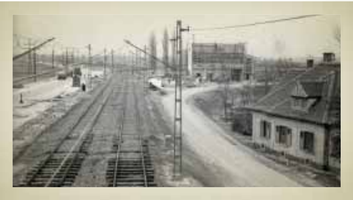
A csepeli gyorsvasút építése a Kvassay hídtól Csepel felé nézve, 1950 (UVATERV, Fortepan)
