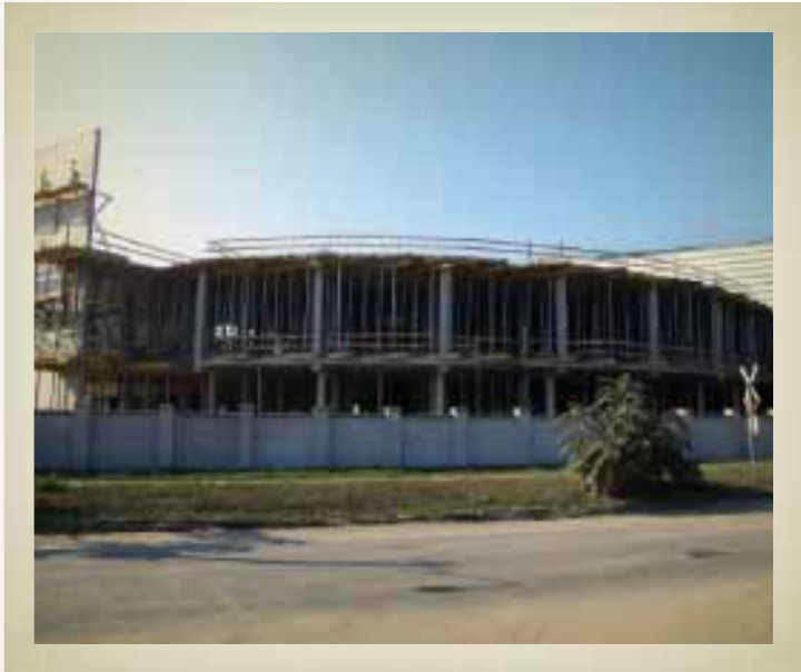
Épül a Ghibli Kft. raktározási központja a kikötőben, az átadásra 2009-ben került sor (Budapesti Szabadkikötő Logisztikai Zrt.)
