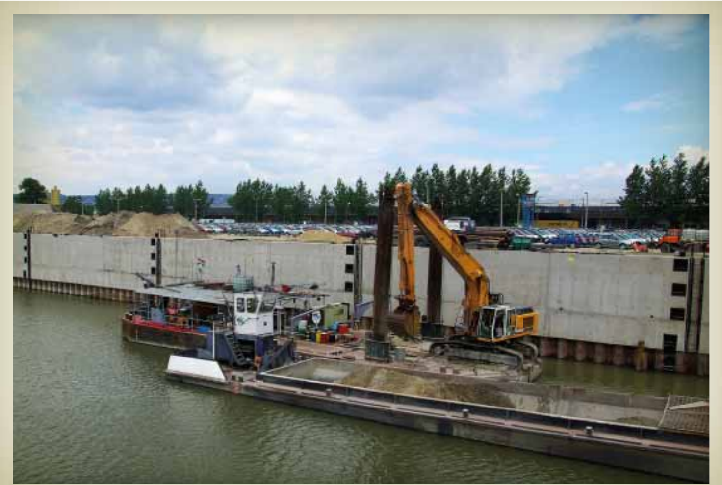
Partfalépítés a kikötő II. számú medencéjénél (Budapesti Szabadkikötő Logisztikai Zrt.)
