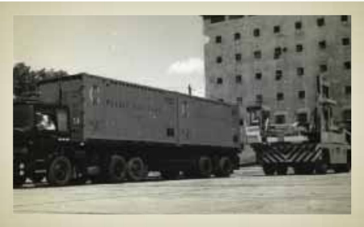
Rába nyergesvontató 2db 20 lábas konténerrel, a jobboldalán a kamionnak egy LANCER konténer mobilдарu áll a konténerterminálban az 1970-es évek közepén
