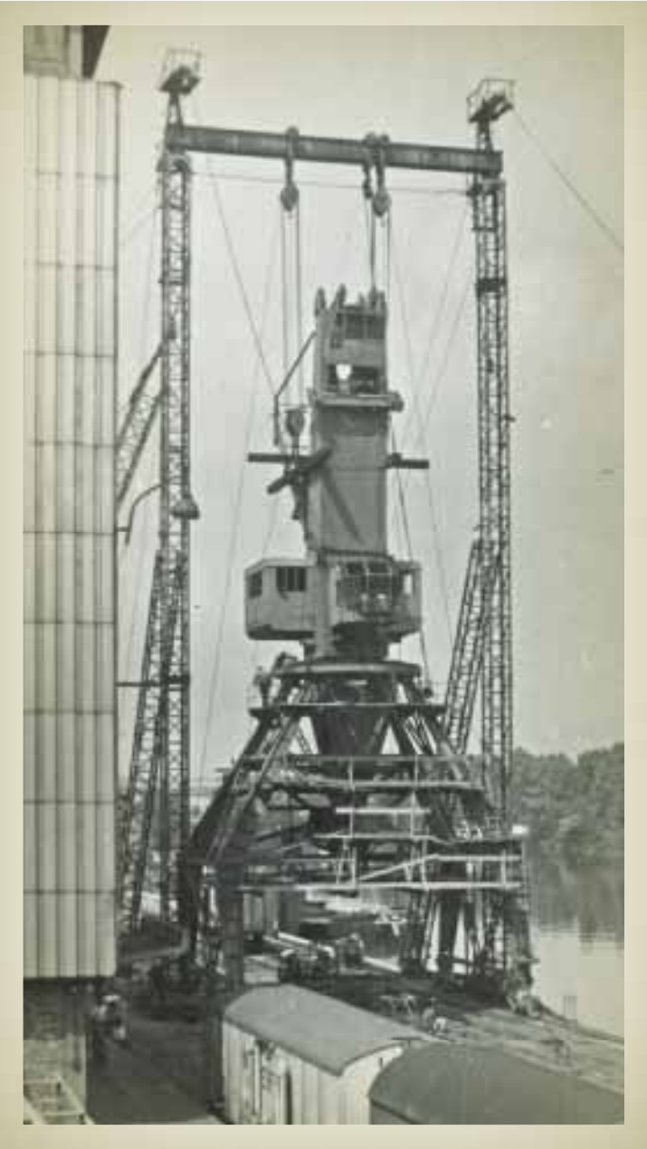
Az egyik új daru szerelése a kikötőben (Magyar Műszaki és Közlekedési Múzeum A.703.13.)
